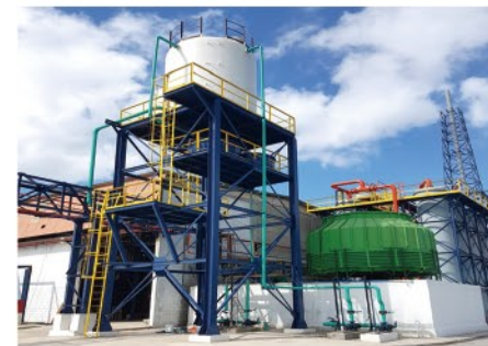
冷却水系统 Cooling water system
