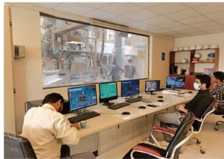
中央控制系统 Central control system
