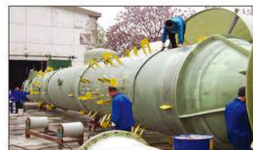
玻璃钢洗涤塔 FRP scrubber
