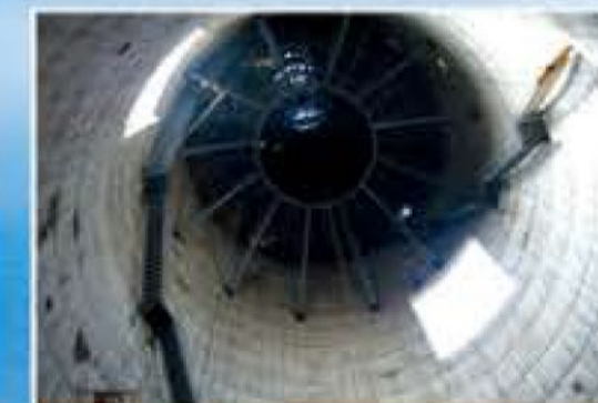
电厂混凝土烟筒内衬玻璃钢工程 FRP lining of concrete chimney
