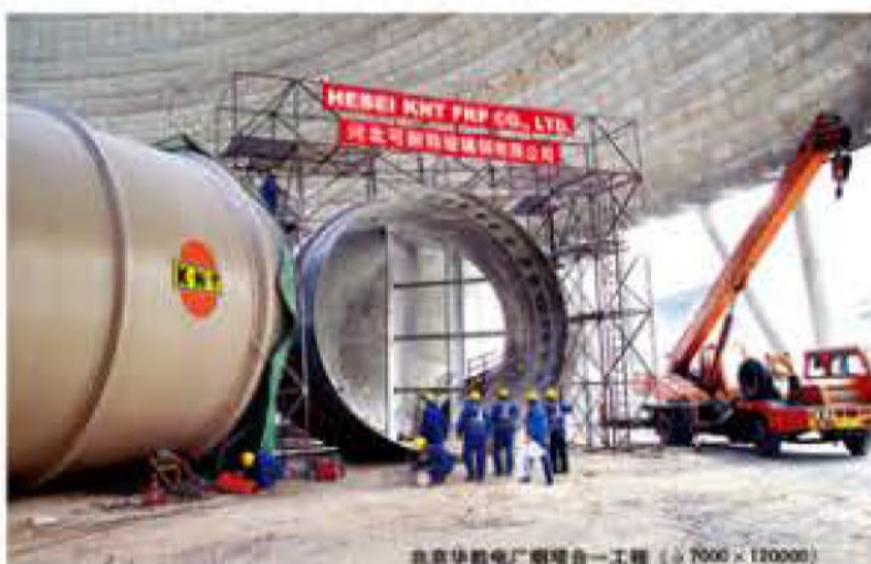
北京华能电厂烟塔合一工程 (φ7000 × 120000)
